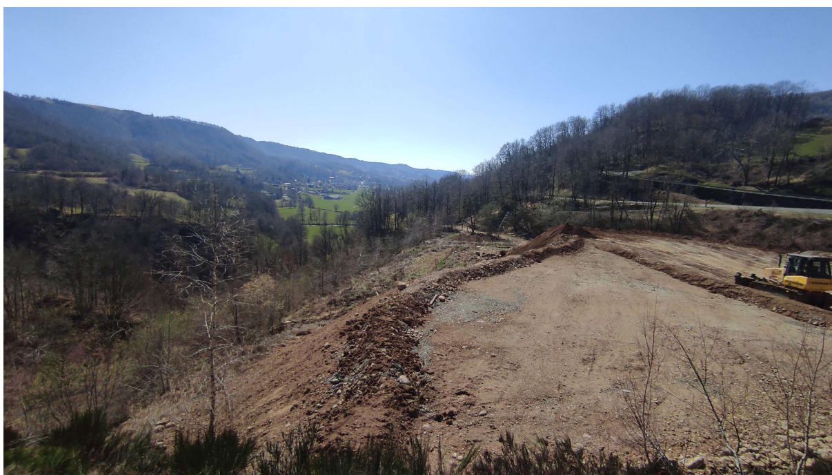
Vue du remblai depuis le Sud de l'aire du Pas de Cère (Source : SEGIC)
